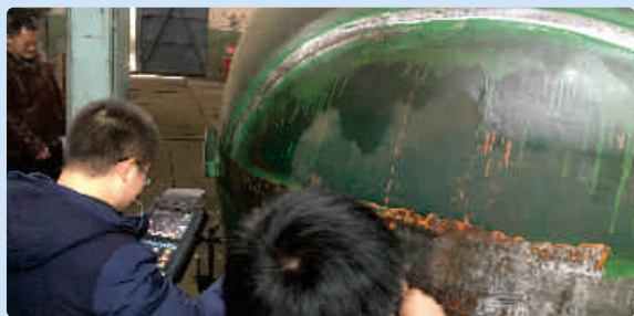
球罐焊缝检测
