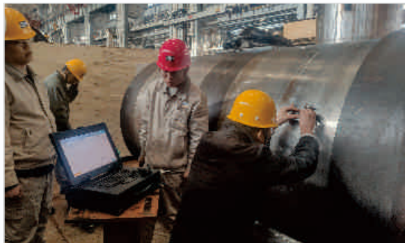
大壁厚焊缝检测
