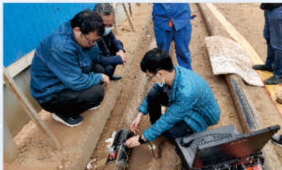
PE管道焊缝检测
