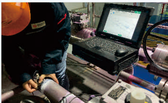
水电管道焊缝检测
