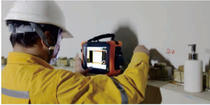
风电塔筒螺栓现场检测
