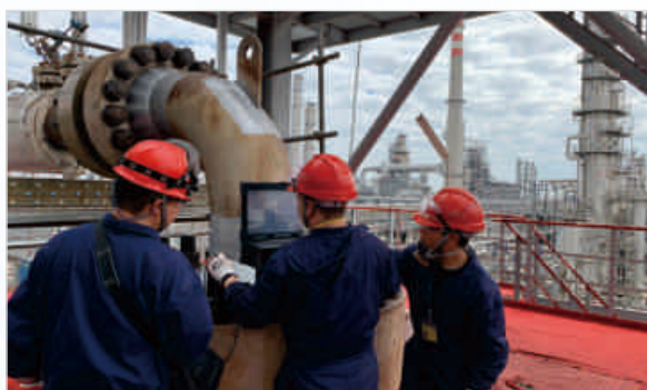
大直径特种设备螺栓检测
