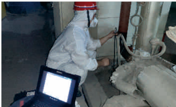
蒸汽管道焊缝检测
