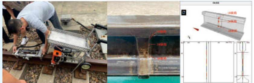
电动扫查装置钢轨焊缝相控阵3D成像检测图
